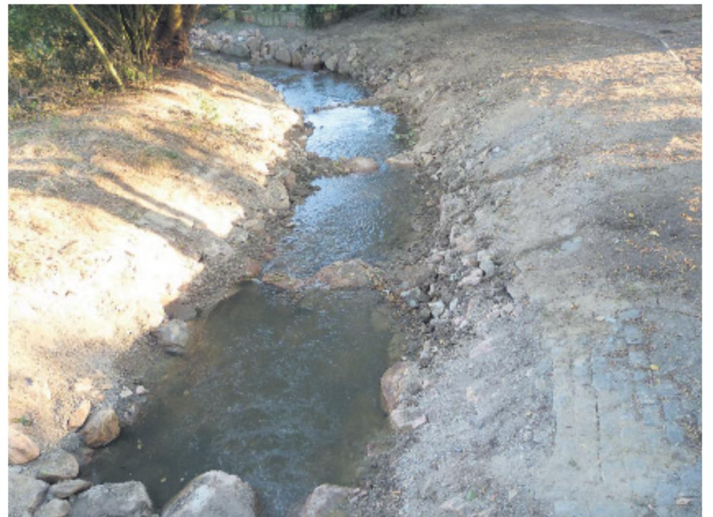
Die Riegelrampen vorn mit Durchlass rechts für die Fische, bei der zweiten Riegelrampe ist links der Durchlass für die Fische und bei der dritten Riegelrampe ist der Fischdurchlass wieder rechts.
